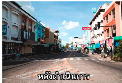
โครงการก่อสร้างระบบไฟฟ้าเคเบิลใต้ดิน พื้นที่เทศบาลนครอุบลราชธานี
